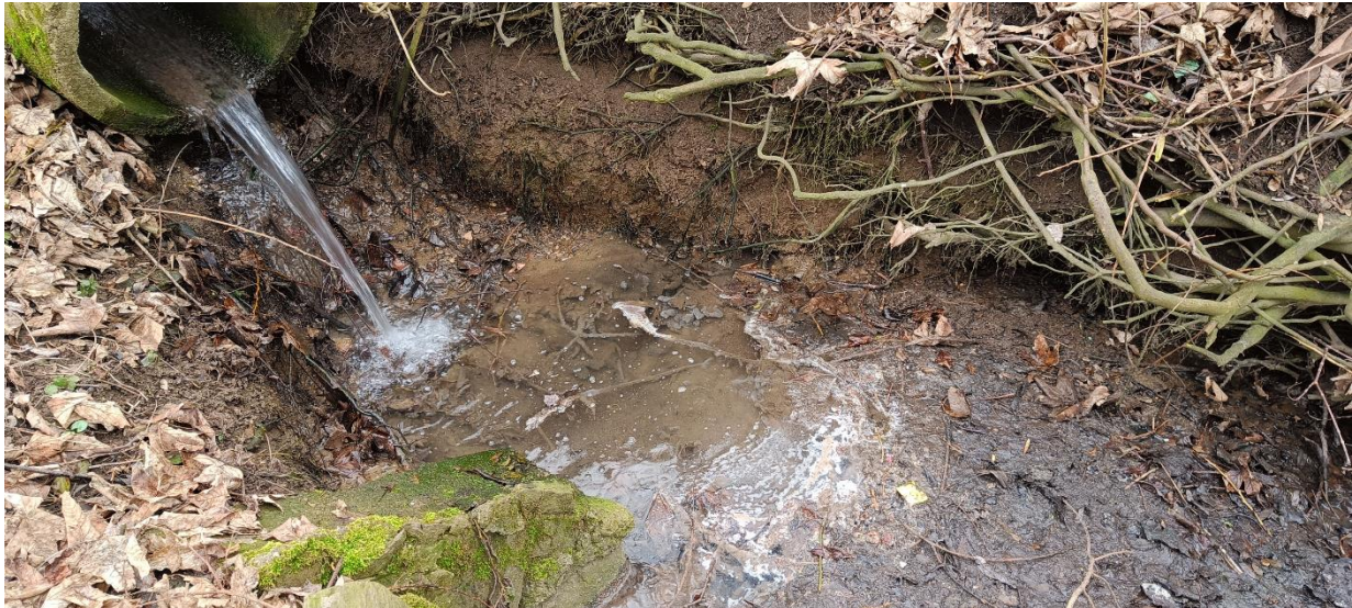
Obrázek 5 Vyústění stávající jednotné kanalizace
